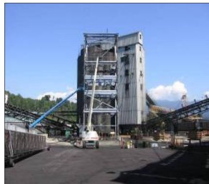
Construcción SGS de un MSS en un Puerto Canadiense
